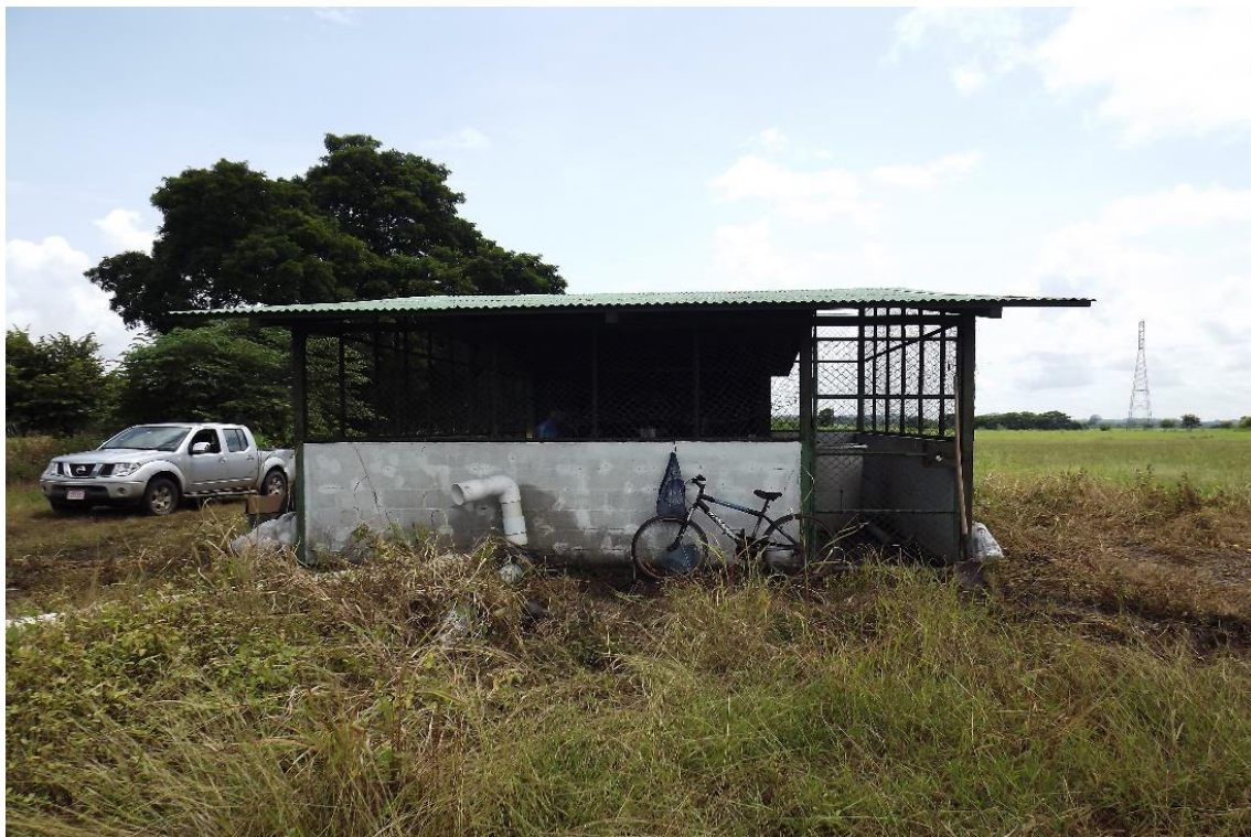
Fotografía # 4: Vista de la caseta donde se ubica el pozo.
